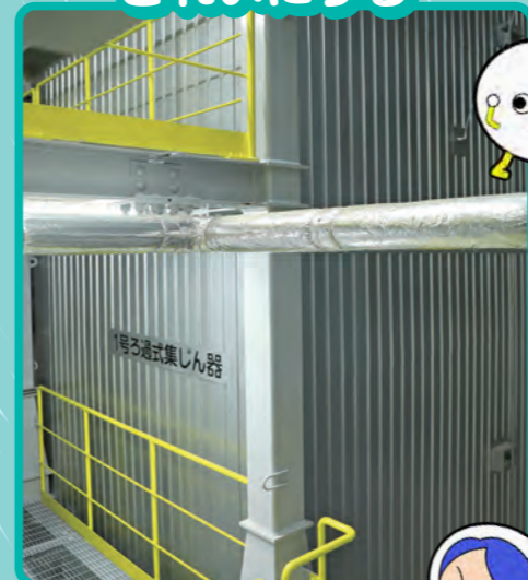
8 ろ過式集じん器 排ガスの中の細かい灰をとり、薬剤と反応させて、排ガスをきれいにします。
